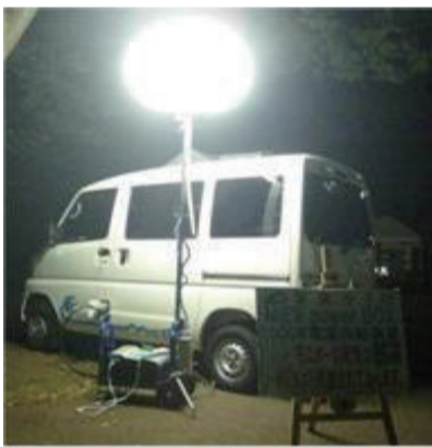
投光機への給電
